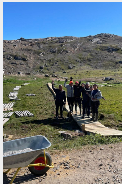
218 trin skulle de unge lægge, før broen over sumpen i Blomsterdalen var færdig. Der er brug for den til både turister og lokale.
